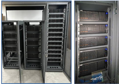
Hệ thống bố máy chủ đang trong quá trình hoàn thiện
